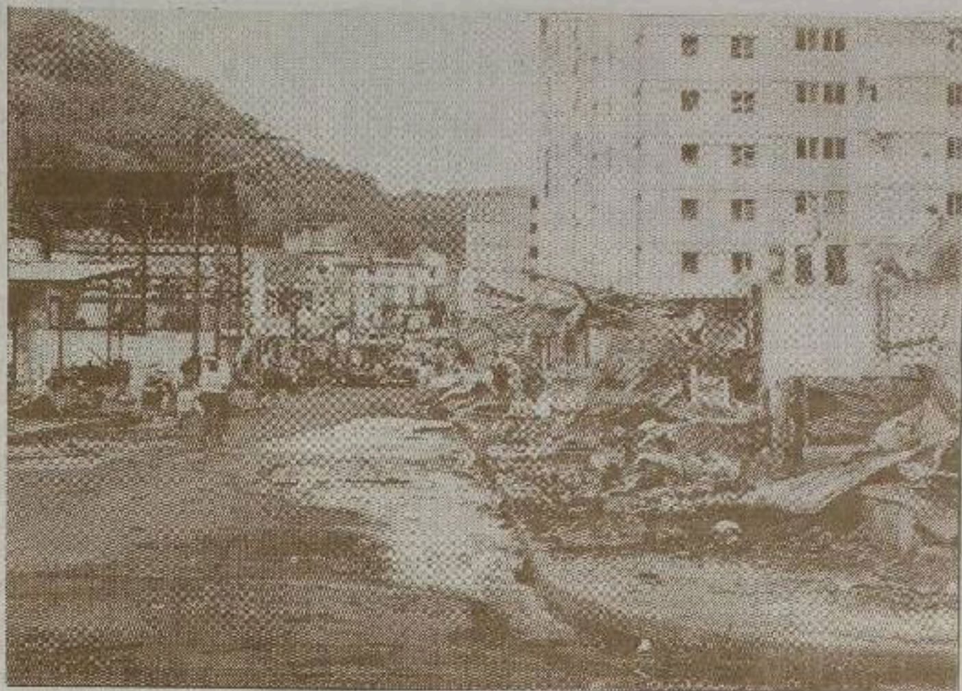
Vistas del Barrio del Chorrillo, destruido durante la invasión de los Estados Unidos a Panamá el 20 de diciembre de 1989. Los afectados y el pueblo panameño reclaman justa indemnización.
